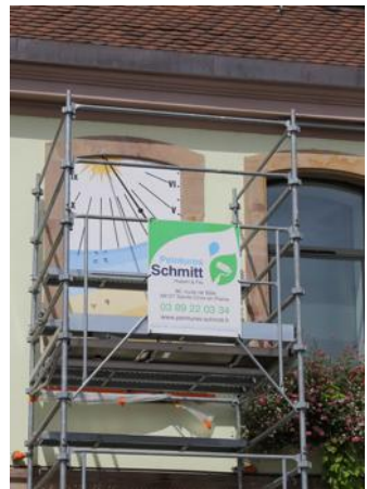
La rénovation du cadran solaire, sur la façade de la mairie de Sainte-Croix, est en cours. PHOTO DNA
